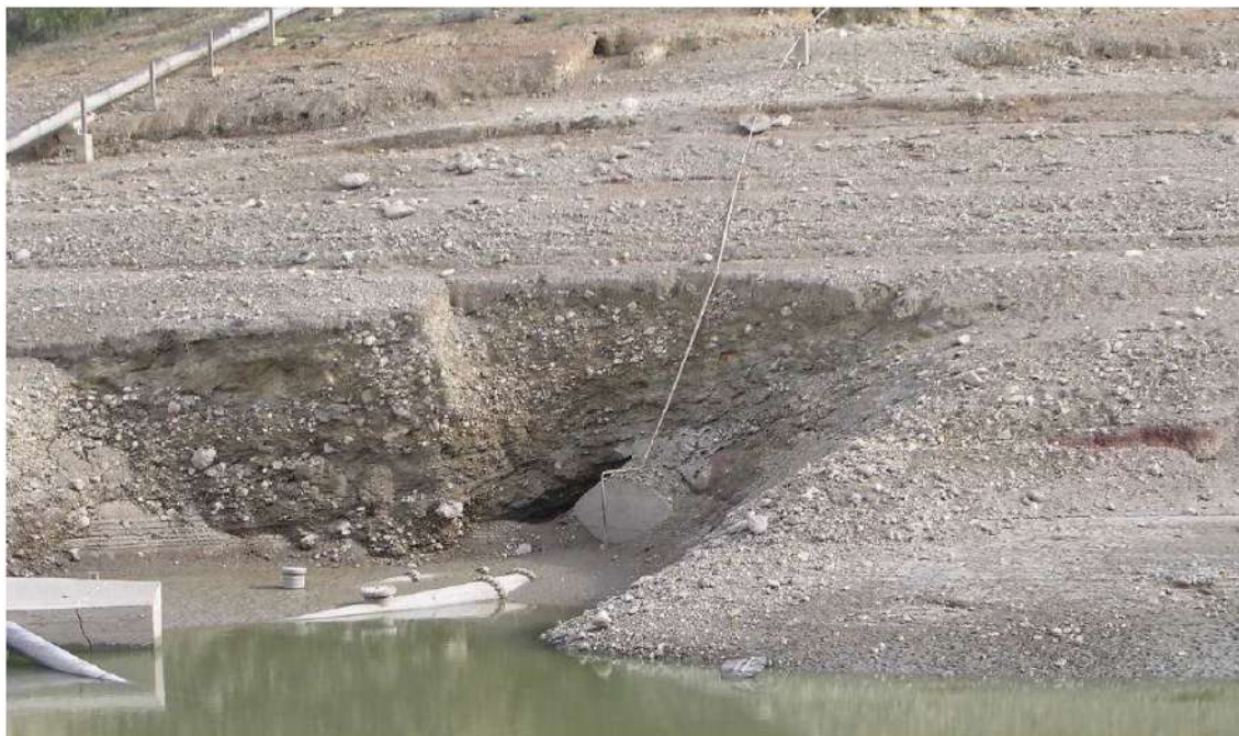
Figure 10 – Vue de l'entrée amont de la galerie.
