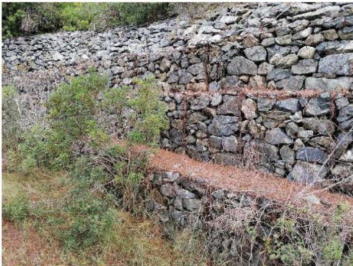
Figure 11 – Vue de l'ouvrage en gabions
