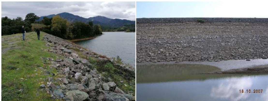
Figures 8 et 9 – Vues du parement amont lors de la vidange de 2007.
